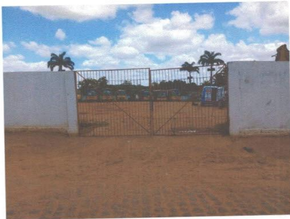
Fachada da Garagem
